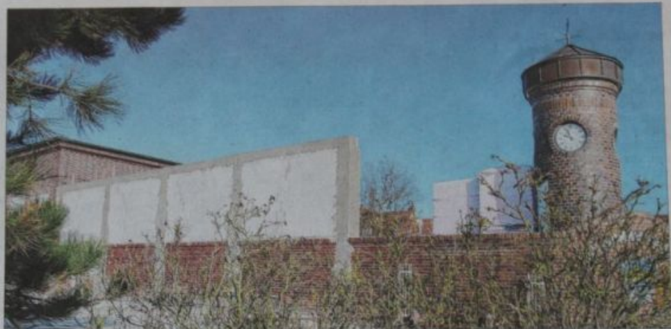
Die weißen Steine lassen die Höhe der fertigen Mauer erahnen. Darauf soll dann auch noch das Faltdach der gläsernen Veranda errichtet werden. BILD: ERDMANN
