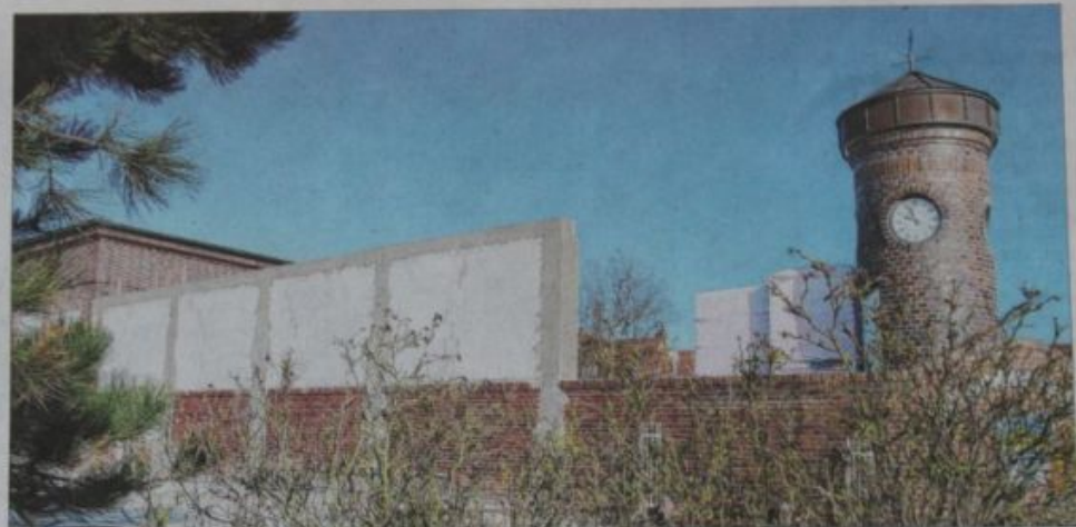
Die weißen Steine lassen die Höhe der fertigen Mauer erahnen. Darauf soll dann auch noch das Faltdach der gläsernen Veranda errichtet werden. BILD: ERDMANN
